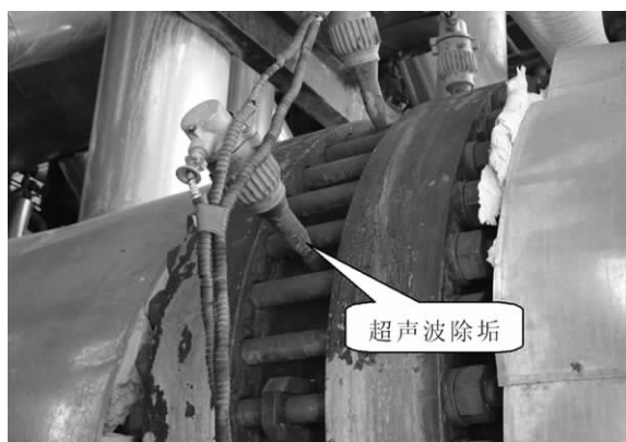
图2 超声波除垢器安装情况
