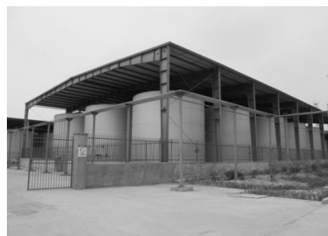
图9 大型基酒贮罐群
